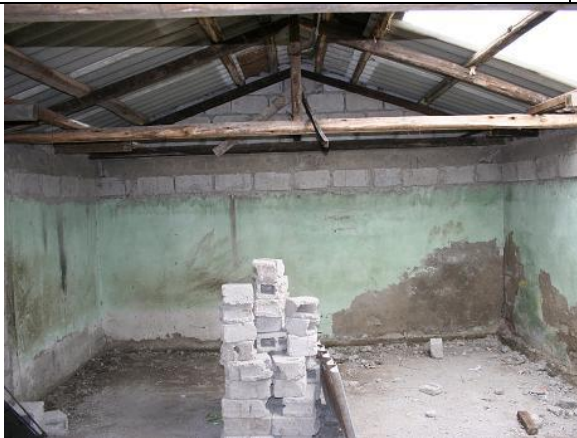
Adecuación de antigua infraestructura .
