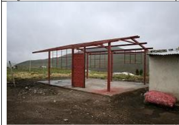
Construcción nueva cocina escolar
