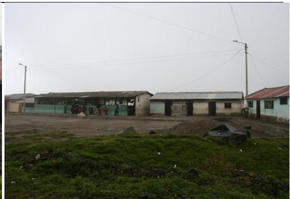
Cambio de techos y adecuación de infraestructura antigua, noviembre 2007.
