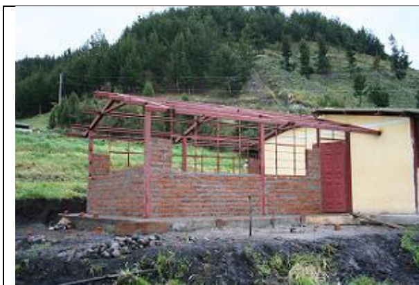
Construcción Nueva Aula
