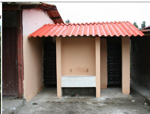
Nueva batería sanitaria octubre 2007.
