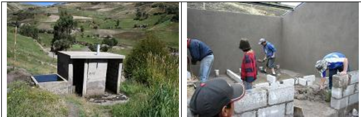
Antiguas baterías sanitarias
