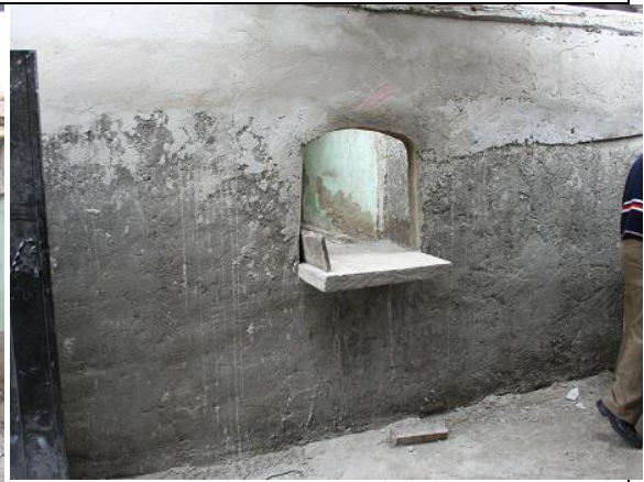
Adecuación de antigua infraestructura septiembre 2007.
