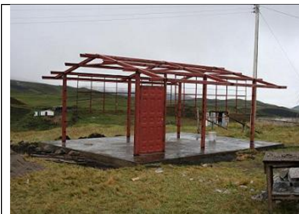
Inicio de construcción.
