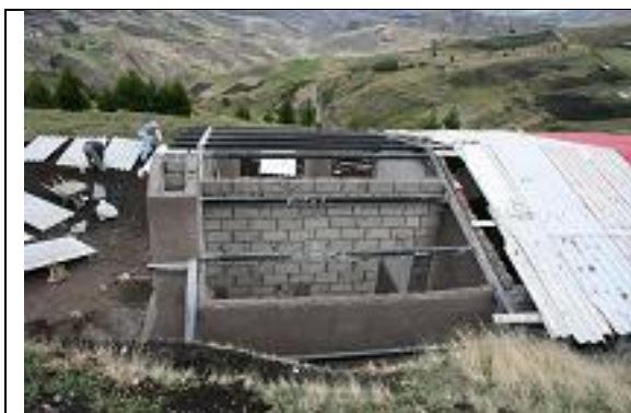
Construcción cocina comedor
