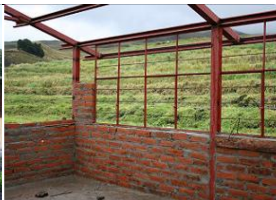
Construcción nueva aula
